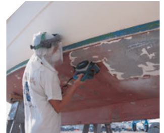
Prace konserwacyjne przytłoczeniach.
