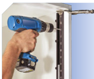
Nawiercanie pod metalowe kołki pod półki.
