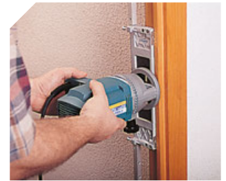
Montaż zawiasów z głowicą CPN66.
